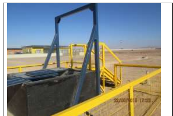
Figura 1. Se realiza mantención de Sistema de Agua Potable.
